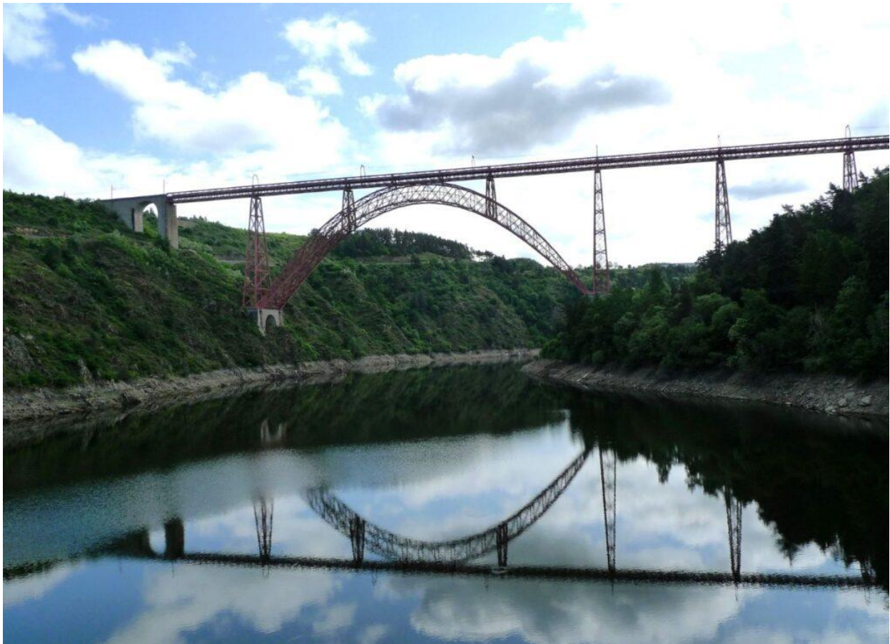
Il viadotto ferroviario di Garabit (Foto © Vittorina Fellin).
