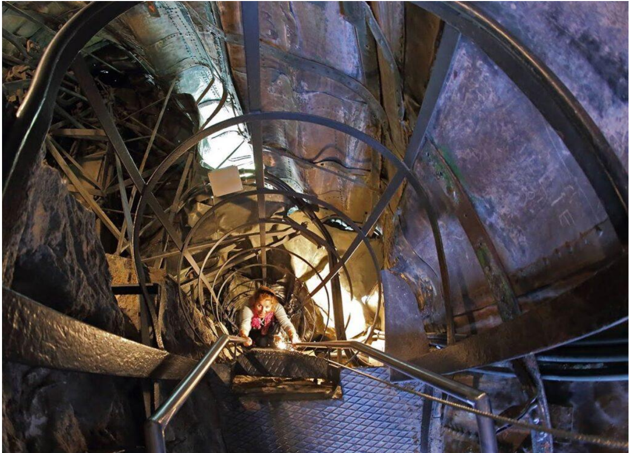
La scala interna che permette di arrivare alla sommità della statua (Foto © Ufficio stampa Archeologist).
