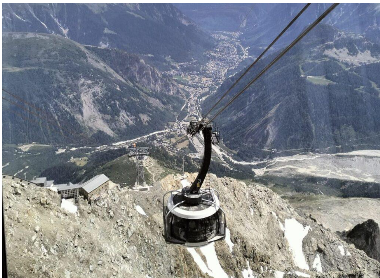
Skyway nel primo tratto da Courmayeur a Pavillon (Foto © Silvia Fissore).
